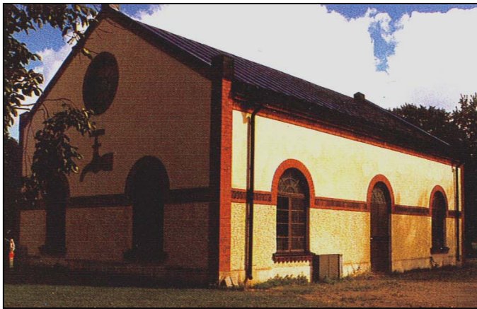
Karlskogas grundvattenverk, byggnad där bl.a. reservkraftmaskinen var placerad 1915-1947.
